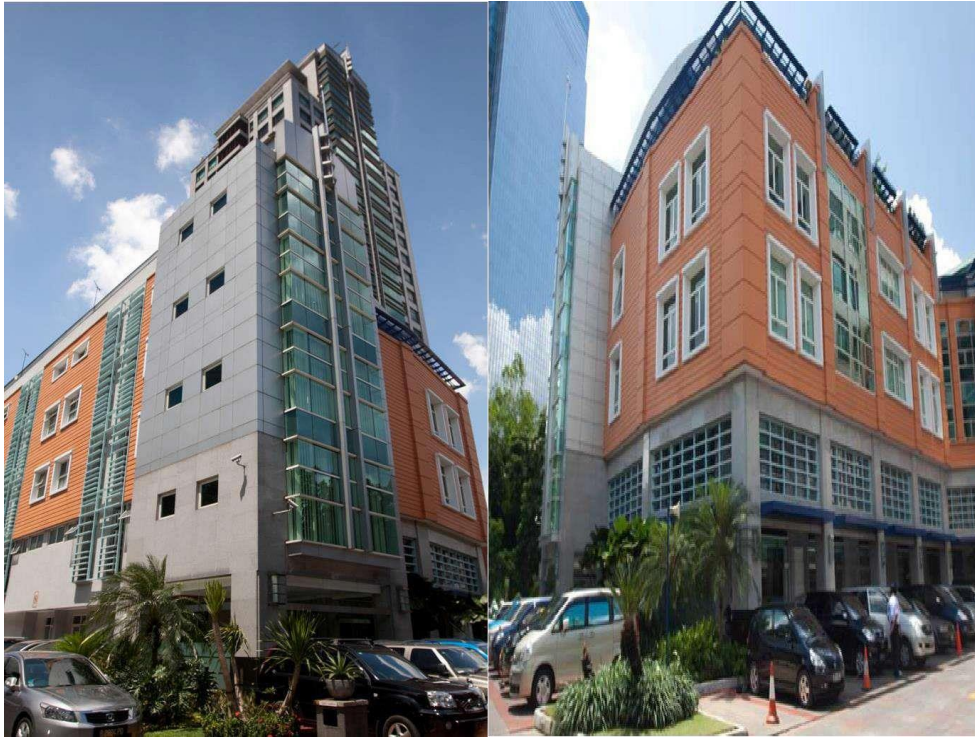
Gambar V.2.6 Gedung Kantor Taman E-33
